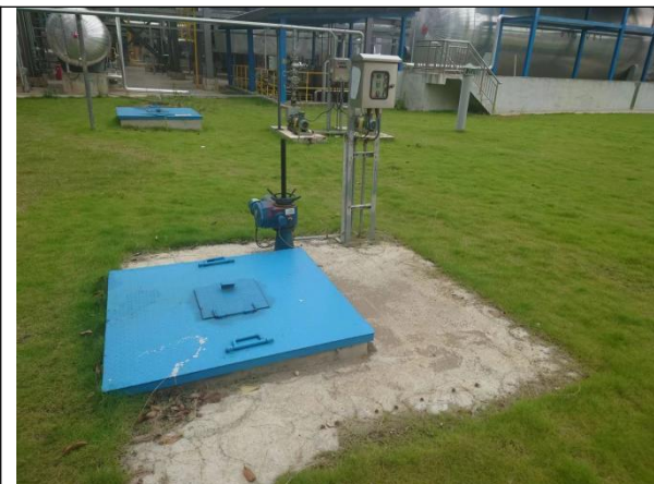
初期雨水收集池
