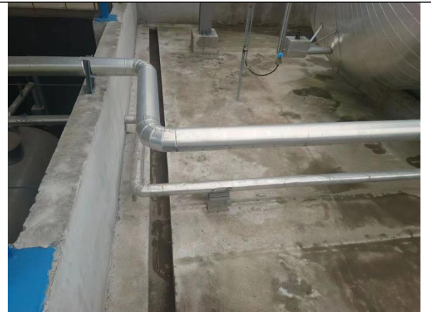
热媒站围堰导流沟
