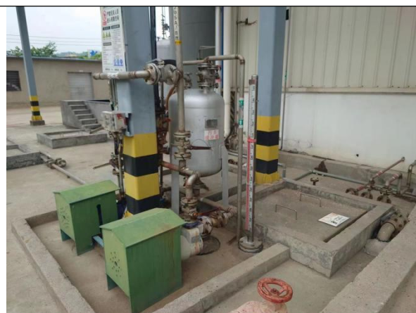
溶剂回收车间污水池
