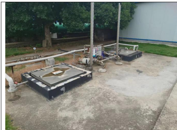
合成车间二污水池
