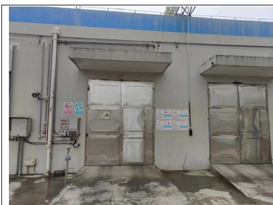
固废暂存区整体情况
