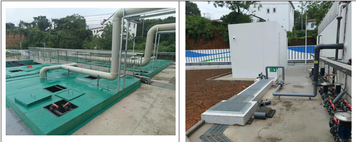
废水处理区整体情况
