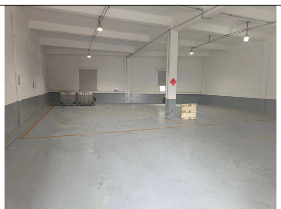
硬化地面完好，无开裂
